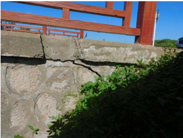
侧墙斜向开裂
