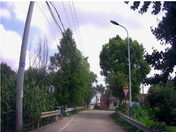
标志牌老化、波形梁护栏缺少端头
