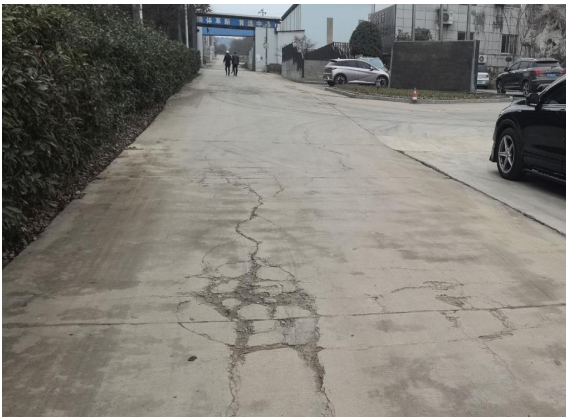
图 4-10 连续破碎板 K2+060～K2+340
