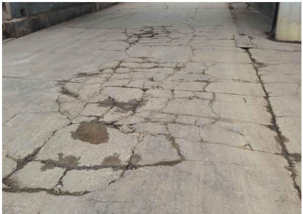
图 4-10 连续破碎板 K2+060～K2+340
