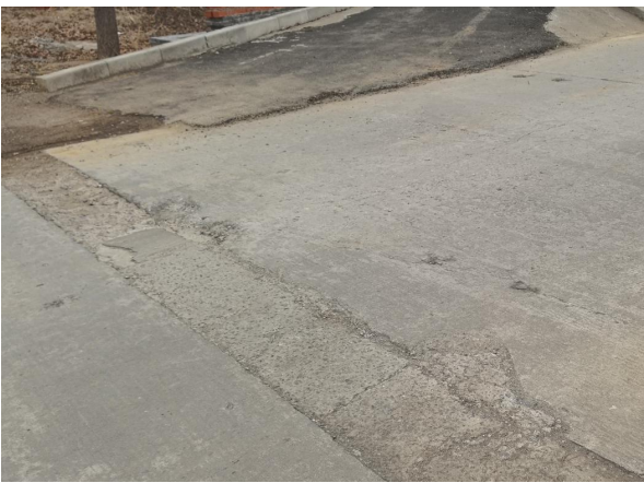
图 4-6 K0+980 横穿管线修补破碎
