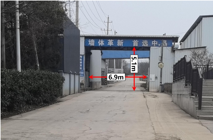
图 4-7 中晶墙体厂跨道路顶棚处现状断面
