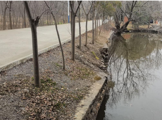
图 4-24 河塘防护挡墙局部坍塌
