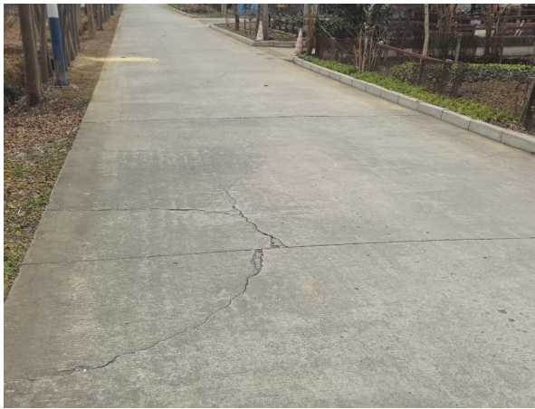
图 4-3 K0+340 破碎板、角隅断裂
