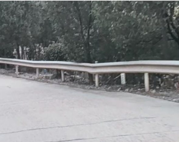
图 4-34 K3+450C 处波形护栏老旧损坏
