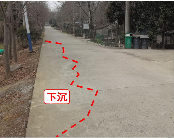
图 4-1 K0+220 纵向裂缝（下沉）
