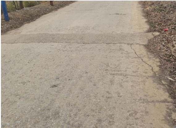
图 4-9 连续露骨 K1+850～K1+930
