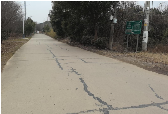
图 4-11 K2+540 裂缝
