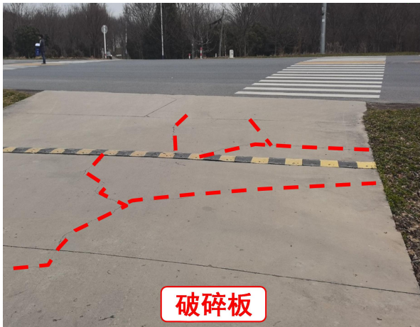
图 4-5 S265 交叉口 破碎板
