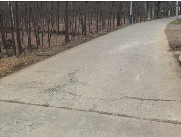
图 4-8 K1+320 破碎板
