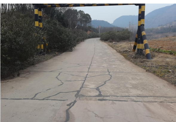
图 4-14 终点处破碎板
