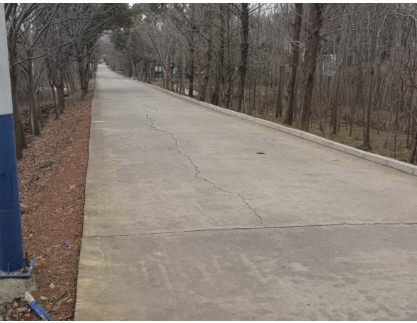
图 4-2 K0+300 纵向裂缝（下沉）
