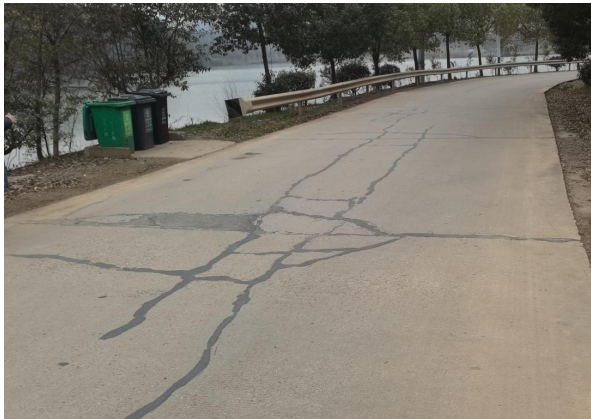
图 4-13 K3+150 裂缝、板角破碎叽浆
