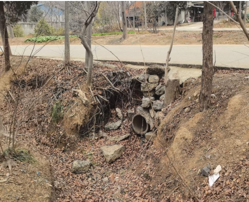
图 4-23 涵洞顶局部坍塌
