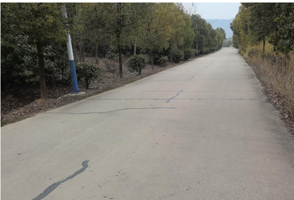
图 4-12 K2+690 裂缝
