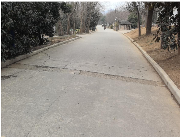
图 4-7 K1+010 裂缝、修补、角隅断裂
