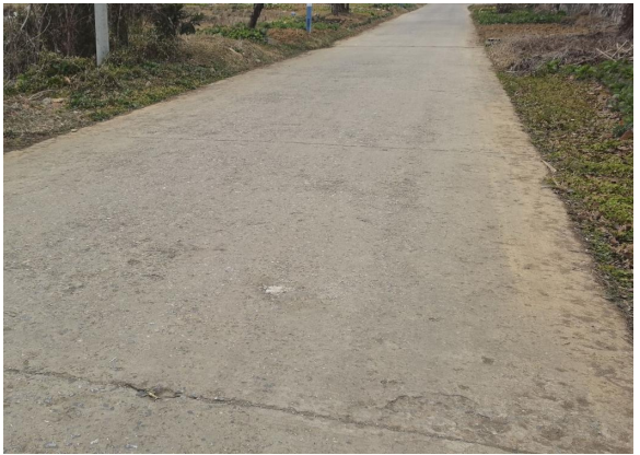
图 4-9 连续露骨 K1+850～K1+930
