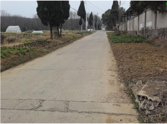
图 4-15 广大畜禽厂段土路肩高出路面 路面排水不畅
